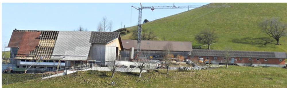
Etappenweise Sanierung des alten Ziegeldachs mit Well-Eternit vor der Montage der PV-Anlage.
