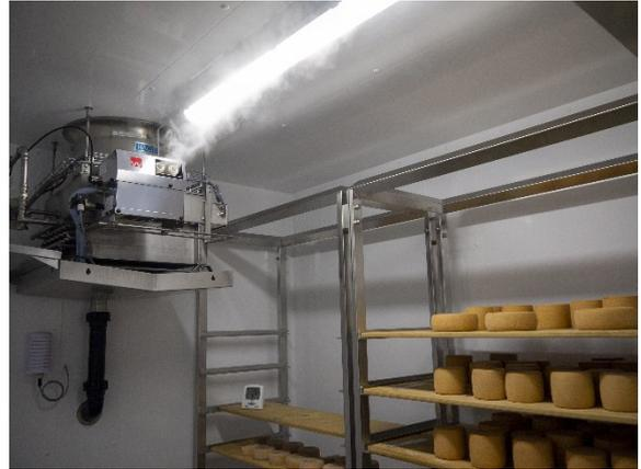
Mit dieser neuen Befeuchtungstechnik ist das BBZN in der Lage, im Modellbetrieb alle in der Praxis gängigen Befeuchtungssysteme wie Hochdruck, Druckluft und Ultraschall den Lernenden und Fachschüler/innen zu demonstrieren.
