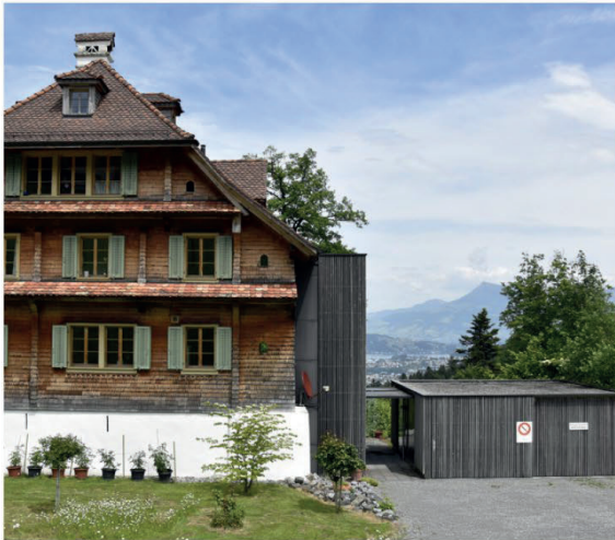
Treppenaufgang an das Gebäude angebaut
