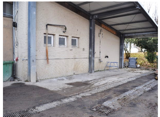
Platz zum Befüllen der Spritze mit Schlauchgalgen, Drainagegitter und Ablauf in Rückhaltetank. Bavendorf (D), Bild H. Hebeisen
