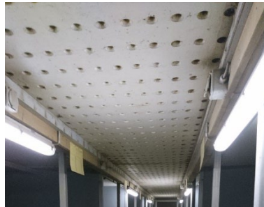
Abb. 2: nur saubere Lochdecken haben einen idealen Luftdurchsatz (Bild: ims)
