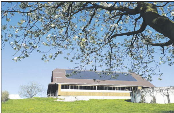
Kombinierte Nutzung der Dachfläche am BBZN Hohenrain für Stromproduktion und als Sonnendach für Heubelüftung
