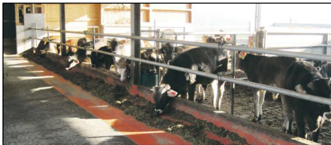
Familie Widmers Offenfrontstall für Masttiere mit Spaltenboden im Fress- und Auslaufbereich und Tiefstroh im Liegebereich. An einer Bauexkursion werden verschiedenste Ställe besichtigt. (Bild Anton Moser)
