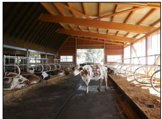
Grosse Öffnungen und eine grosszügige Stallhöhe für eine gute Frischluftzirkulation im Stall. (Foto: Astrid Lussi)
