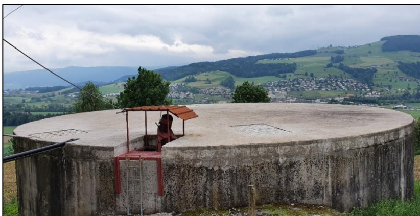
Güllelager mit einer nachträglich erstellten Betonabdeckung.
