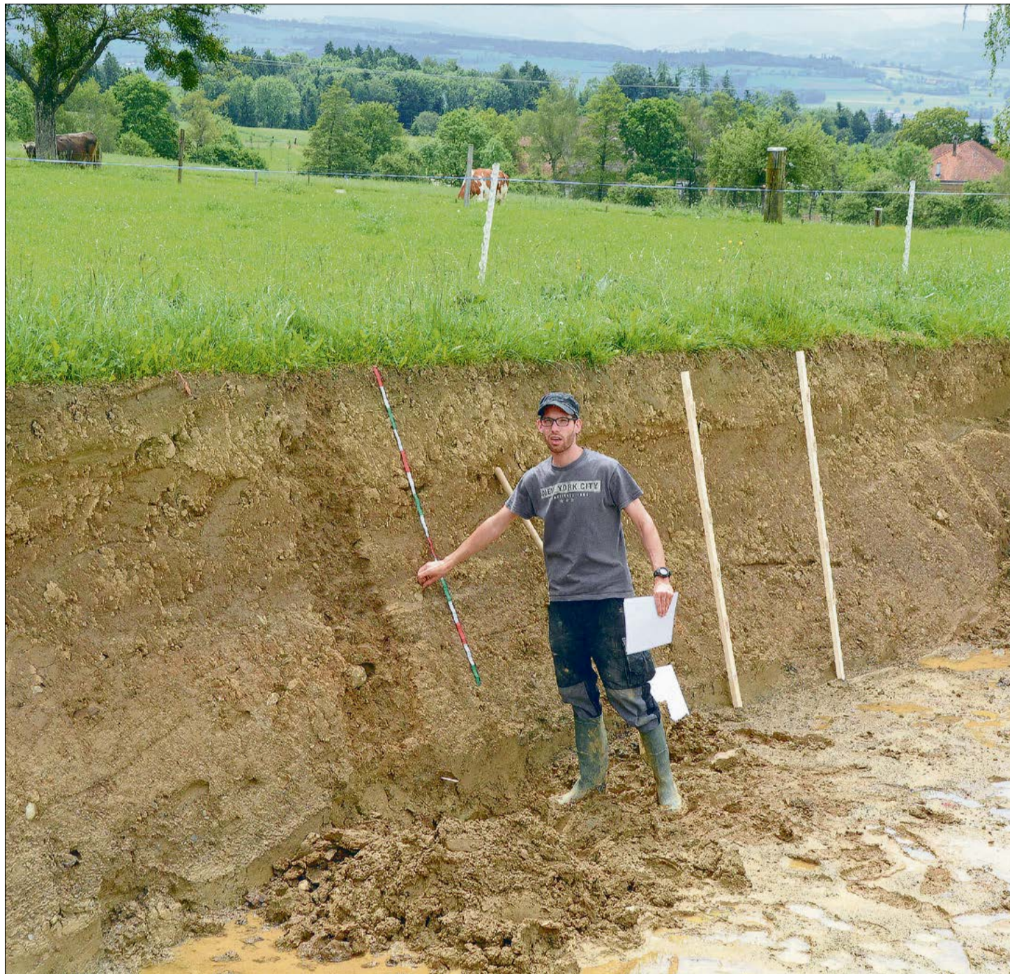
Bodenberater Felix Etterlin in der Baugrube für den neuen Legehennenstall auf dem Betrieb Oberlehn. Fachgerechte(r) Bodenabtrag und -verwertung bedingen bessere Kenntnisse der Struktur und Funktionen des Bodens. (Bild Josef Scherer)
