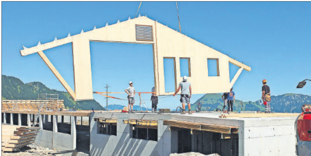
Mit dem Aufrichten, unterstützt vom Kran, nimmt das Bauwerk auf der Kernser Alp Grossächerli Gestalt an. (Bilder: Josef Niederberger)
