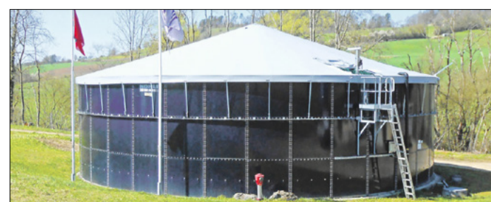
Silodach auf einem emaillierten Güllelager. Zeltabdeckungen eignen sich vor allem bei grossen Durchmessern.
