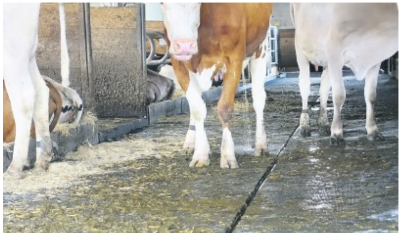
3D-Gummiauflage mit Gefälle zur Harnrinne in einem Rindviehstall. Rascher Harnabfluss reduziert die Ammoniakbelastung markant. (Bild: Markus Bucheli)
